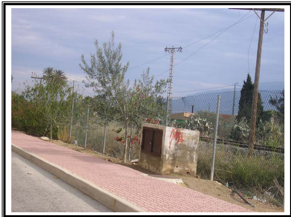
Borde Filipinas arqueta existente riego calle Villalar
