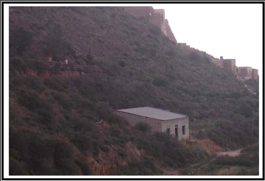
Nave a demoler, ladera del Castillo.
