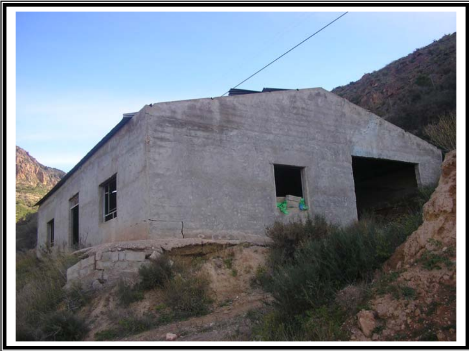
Nave a demoler, ladera del Castillo.
