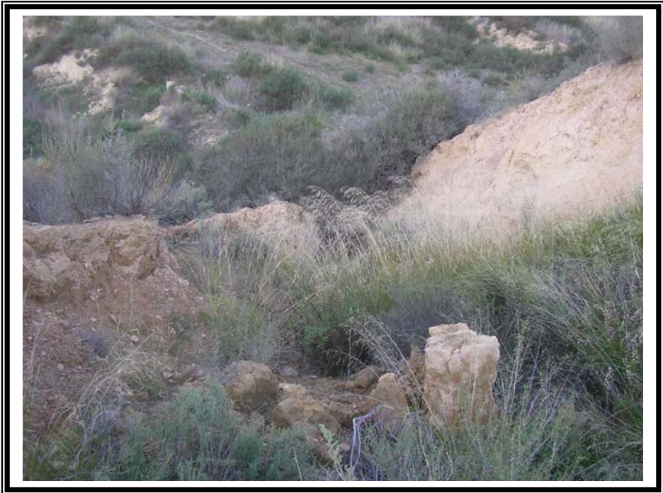
Talud a reponer con escollera.
